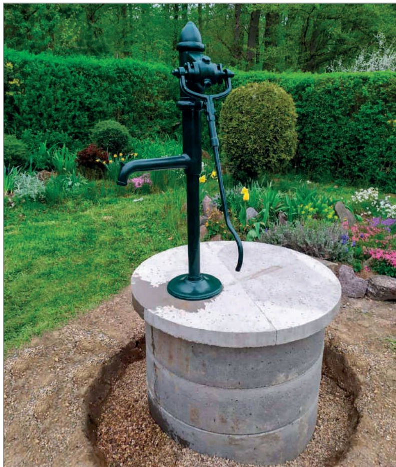
Ukázka realizace nové studny s pumpou STANDARD T v zahradě.
